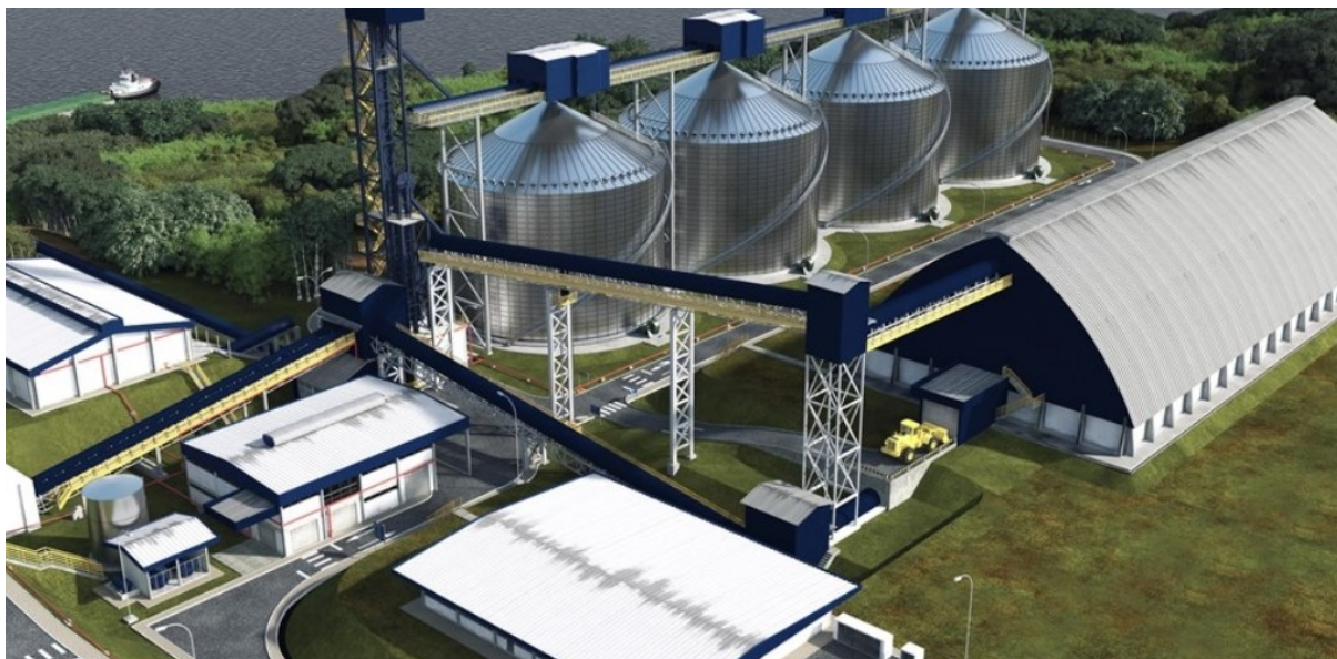
Figura 29: Armazenagem Estação de Transbordo
