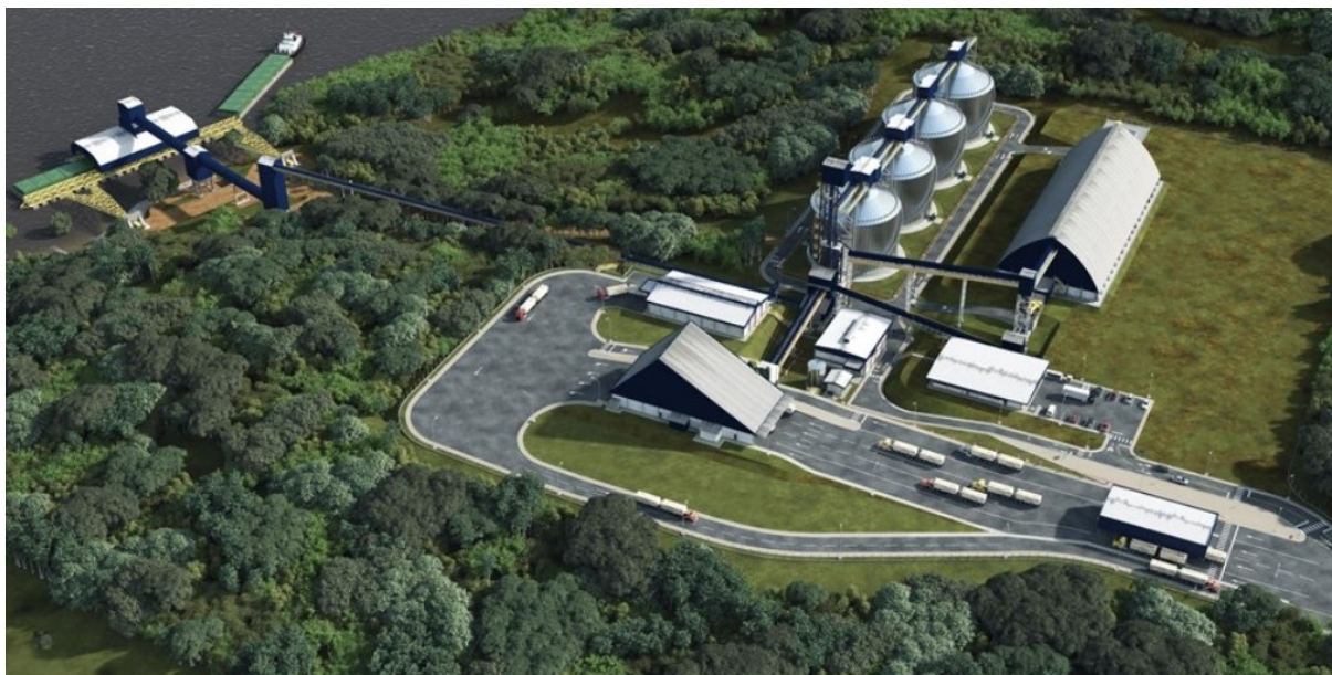
Figura 28: Chegada dos Caminhões na Estação de Transbordo
